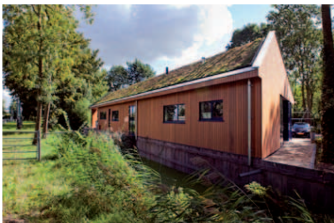
De praktijk is volledig duurzaam gebouwd; het dak is bedekt met vetplantjes
